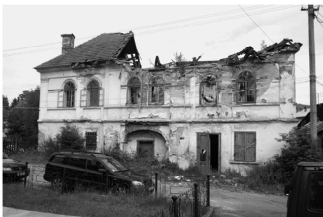
Casa parohială reformată, fațada principală.
