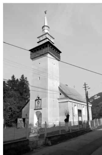
Biserica ortodoxă, vedere din spre sud-vest.
