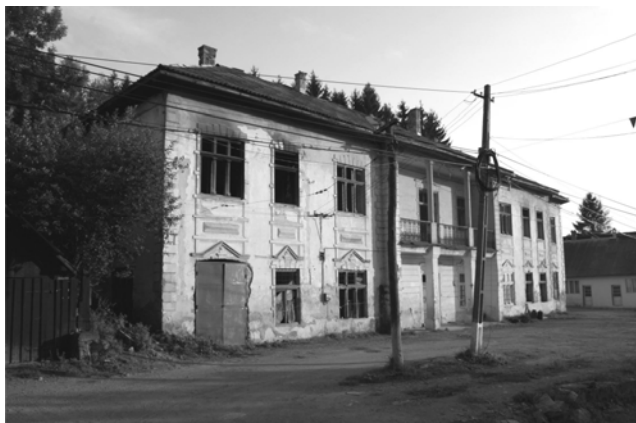
Palatul administrativ, vedere dinspre est.
