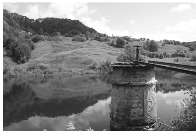
Tăul Corna, acumularea de apă; în prim-plan turnul de control al nivelului apei.
