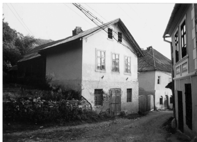
Casa parohială unitariană, imagine dinspre nord.
