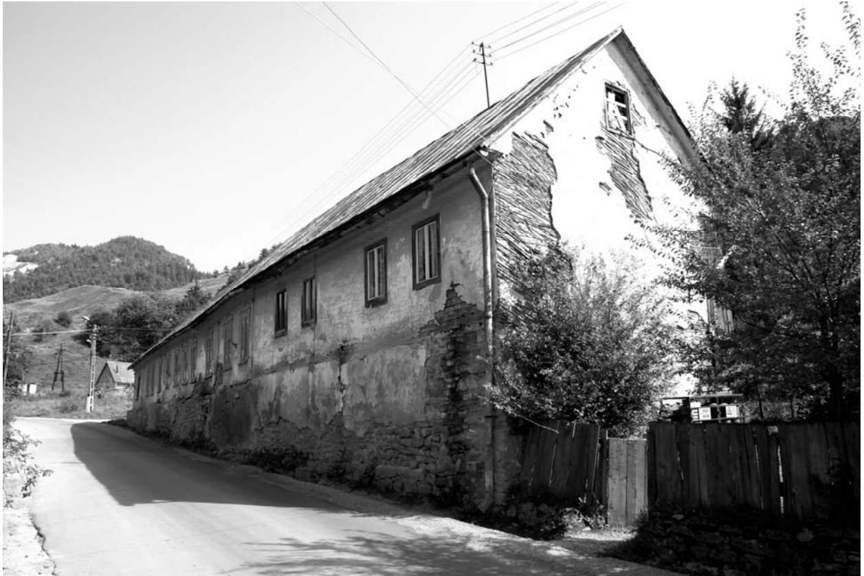
Casa - vedere dinspre strada principală: nivelul pivnițelor, puternic înălțat, preia panta străzii
