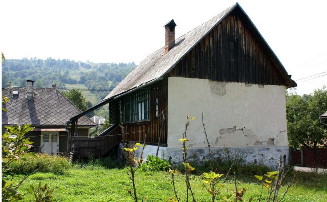
locuința - vedere cu scara de acces la nivelul principal
