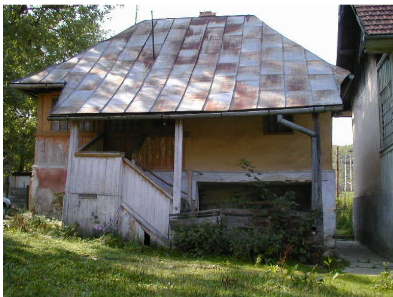
locuința – vedere din curte, cu târnațul și scara întoarsă sub poala foarte largă a acoperișului
