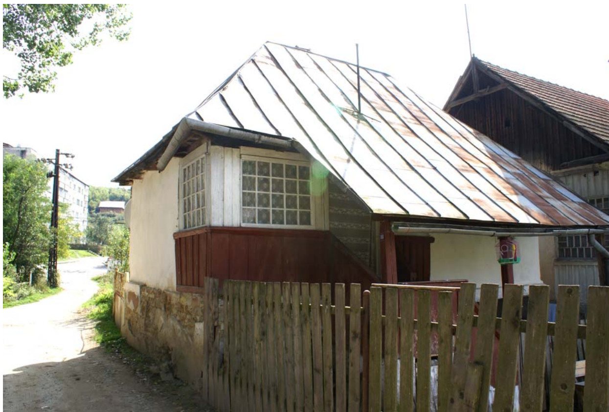
locuința – vedere cu zona de acces
