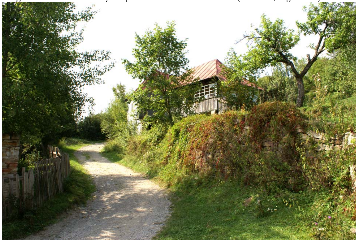
locuința - în prim-plan, în dreapta, zidul de terasare și de delimitare a proprietății, din zidărie seacă
