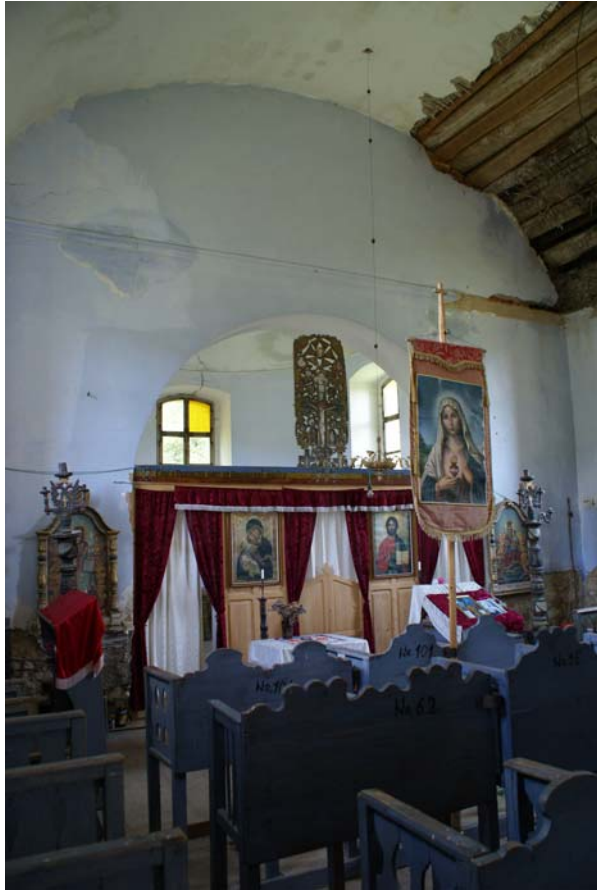
interiorul bisericii – catapeteasma de zid; bolta falsă, din dulapi de lemn și tencuială pe șipci;
