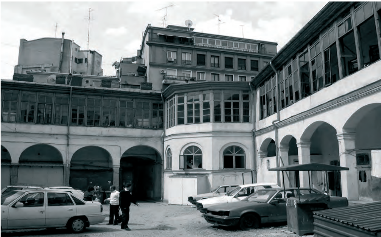
Fig. 3. Curtea interioară a hanului Patria - zona scărilor.
