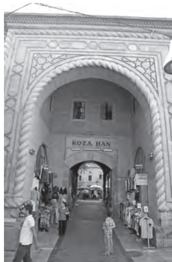
Fig. 22. Main entrance of Koza Han – Bursa (Petru Mortu).
