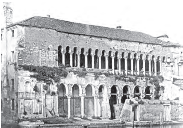
Fig. 4. Fondaco dei Turchi before restoration (Concina 1997, fig. 64).
