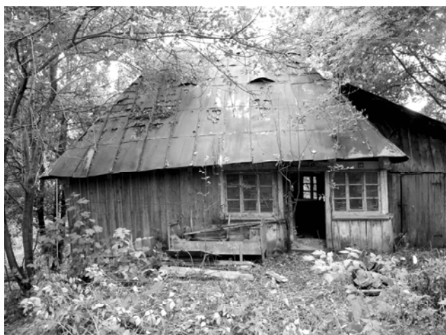
Casa nr. 1248: fațada dinspre curte.
