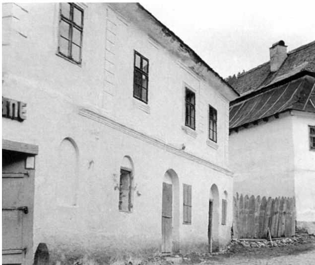
Casa cantorială unitariană: imagine din anii 1970 (M. Bonfert, V. Wollmann, „Die Betriebsgebäude des Montanwesens in Roșia Montană”, în Silber und Salz in Siebenbürgen , Bd. 4, Bochum, 2002, p. 200).
