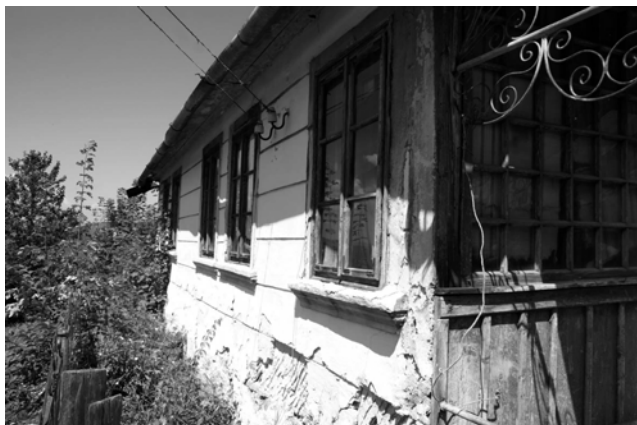
Casa nr. 475: fațada principală (sud), îndreptată spre curte și spre Valea Roșiei.
