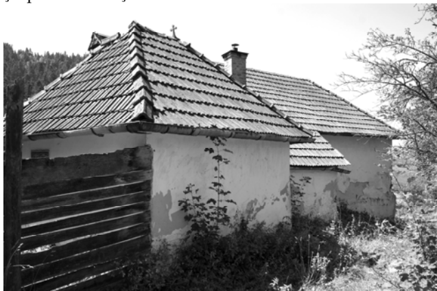
Casa nr. 475: frontul opac și continuu îndreptat spre stradă (nord).
