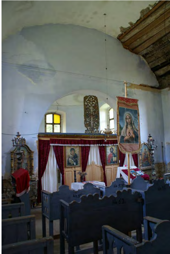
interiorul bisericii – catapeteasma de zid; bolta falsă, din dulapi de lemn și tencuială pe șipci;
