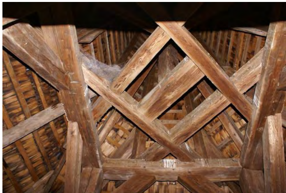
structura șarpantei turnului; se păstrează și învelitoarea originală, din șindrilă, sub învelitoarea actuală de tablă
