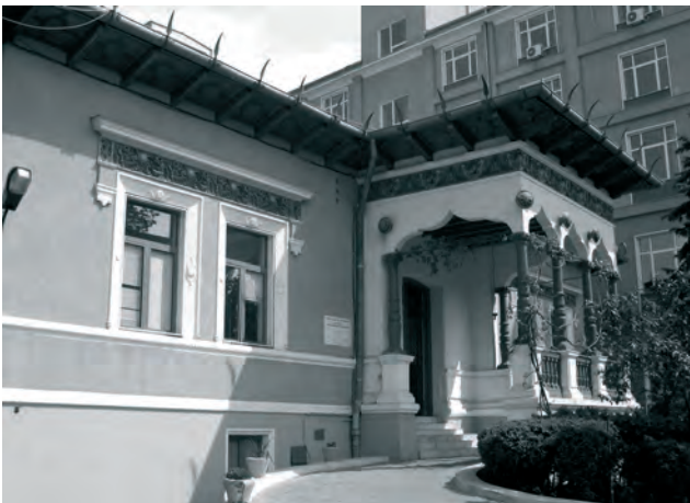
Fig. 4. Casa Lahovary „sufocată” de clădirea Spitalului.
